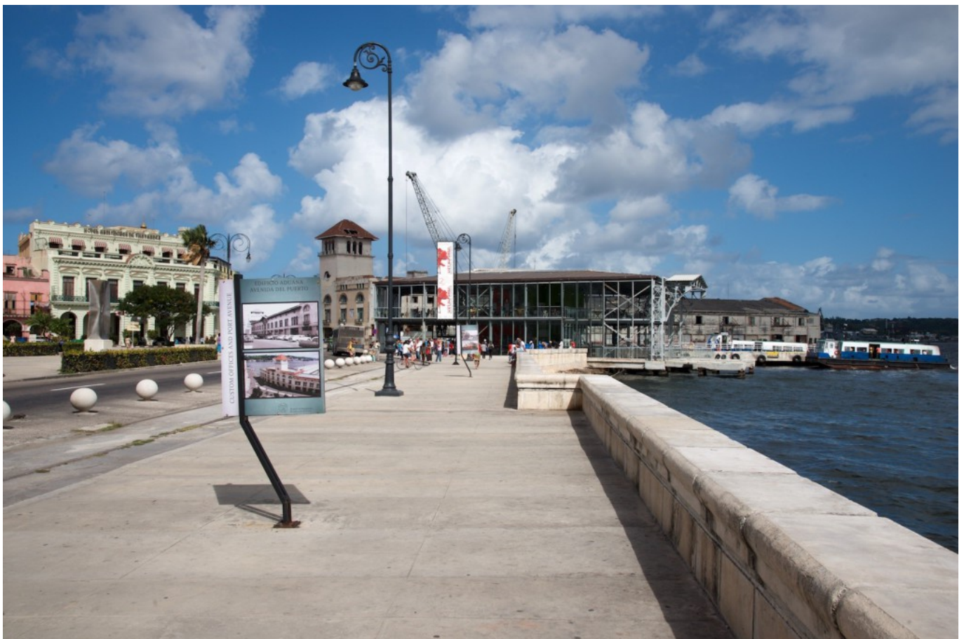
Nuevo paseo marítimo entre Emboque de Luz y Almacén de la Madera y el Tabaco
