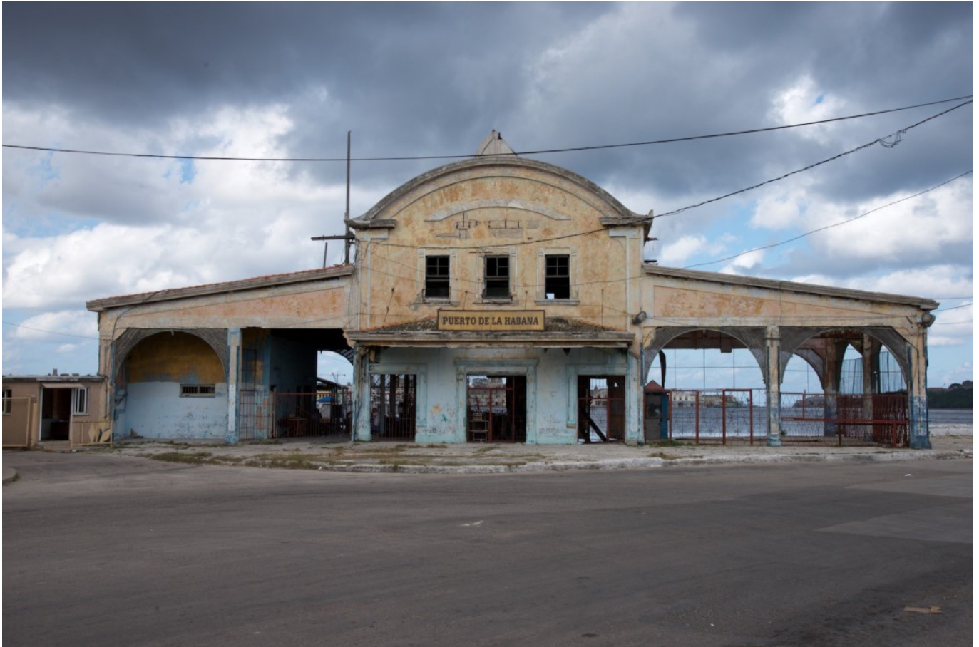
Terminal para pasajeros de la bahía en Regla, actualmente en desuso
