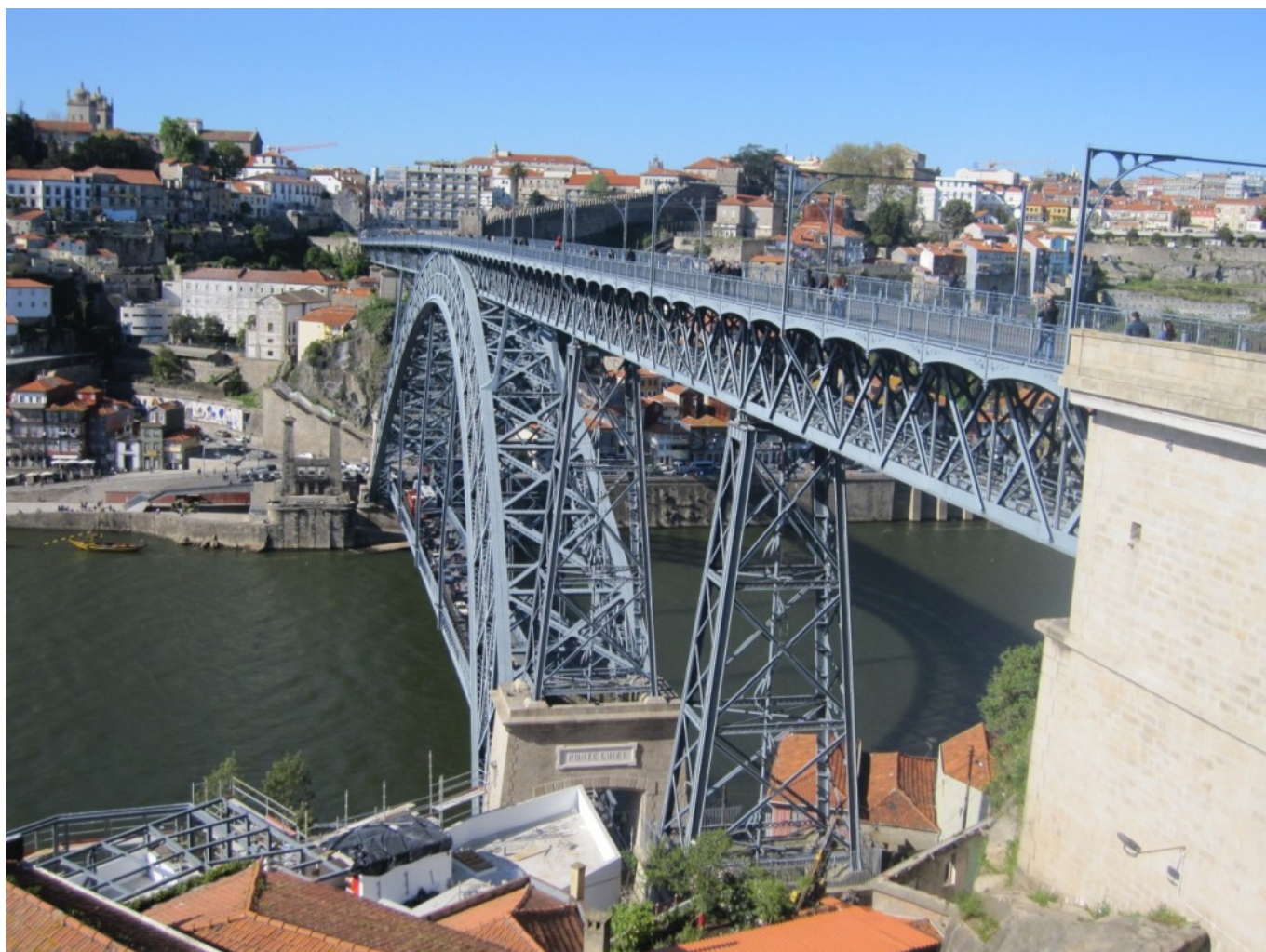
Ponte D. Luis I.
