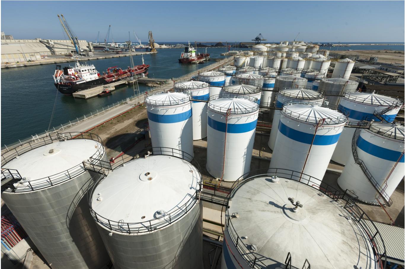
Vista aérea de operativas en el Muelle de la Química. (Fuente: Autoridad Portuaria de Tarragona).
