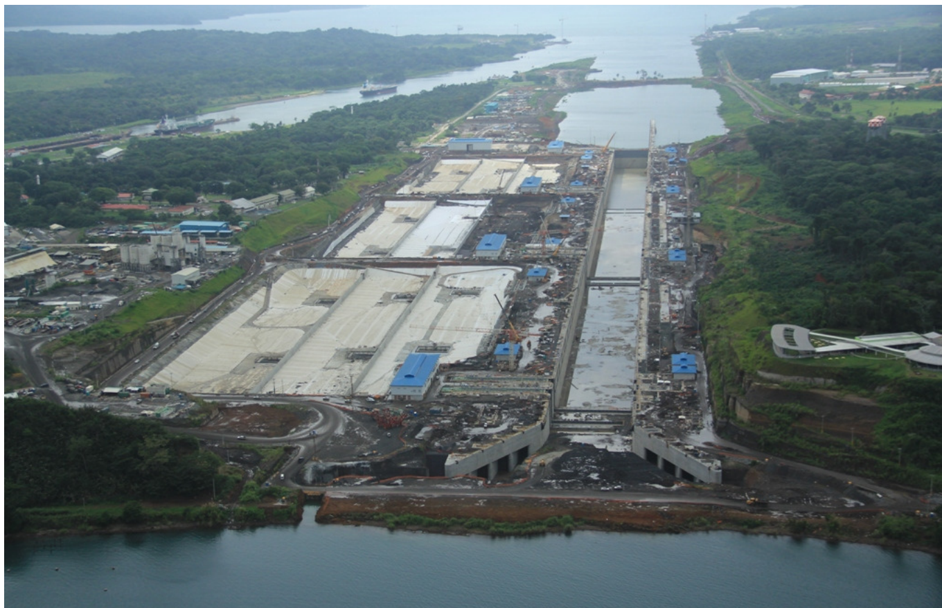
Lado Atlántico, imagen del avance de las obras en julio de 2015.
