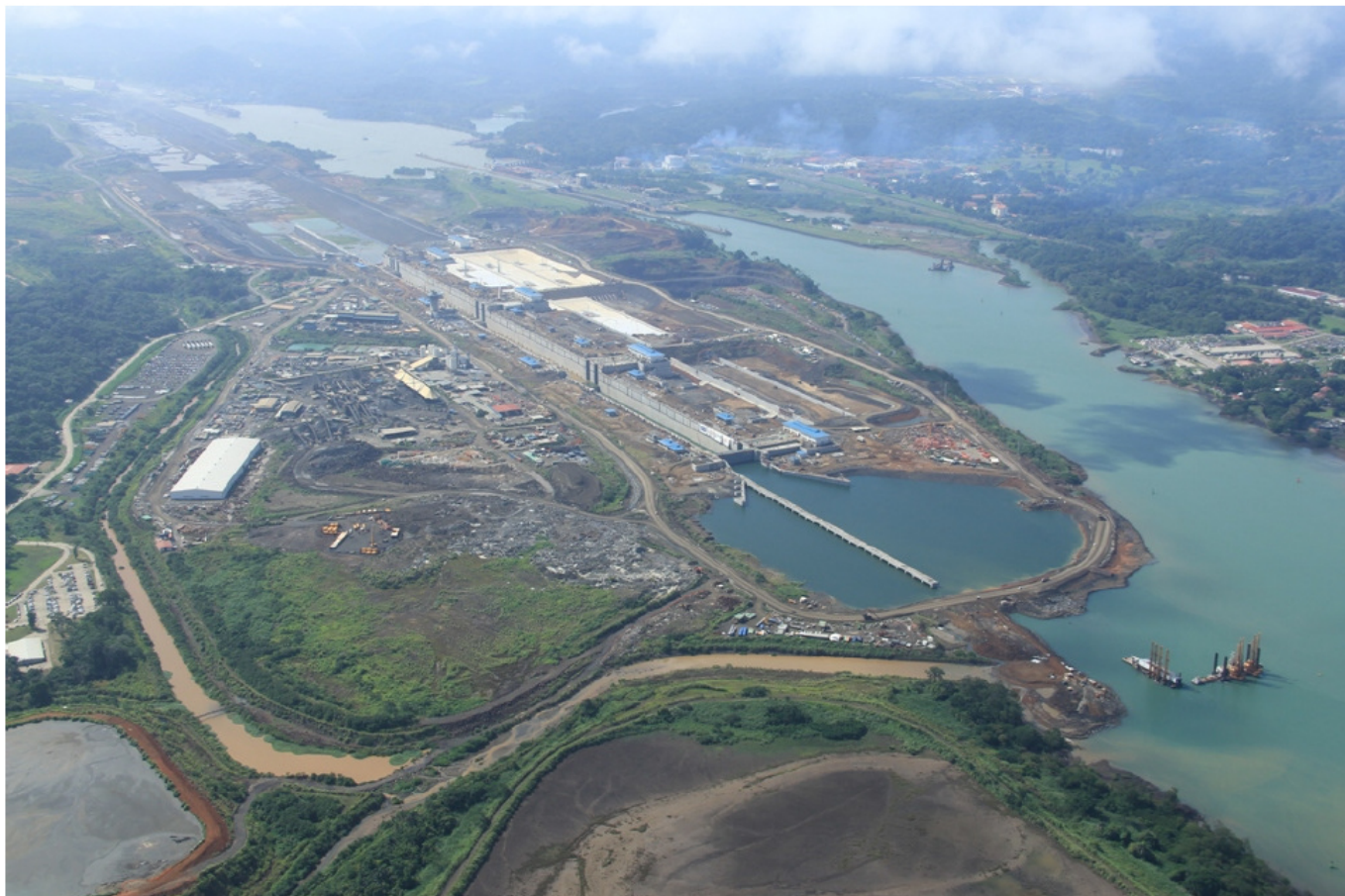
Lado Pacífico, imagen del avance de las obras en julio de 2015.
